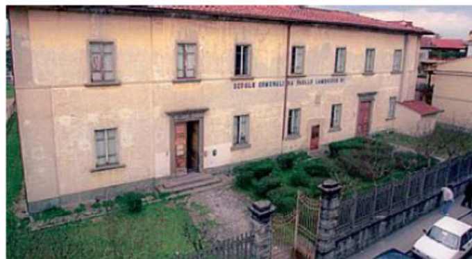
Le ex scuole Lambruschini sono destinate a diventare un centro polifunzionale. Il progetto ha subito vari stop
